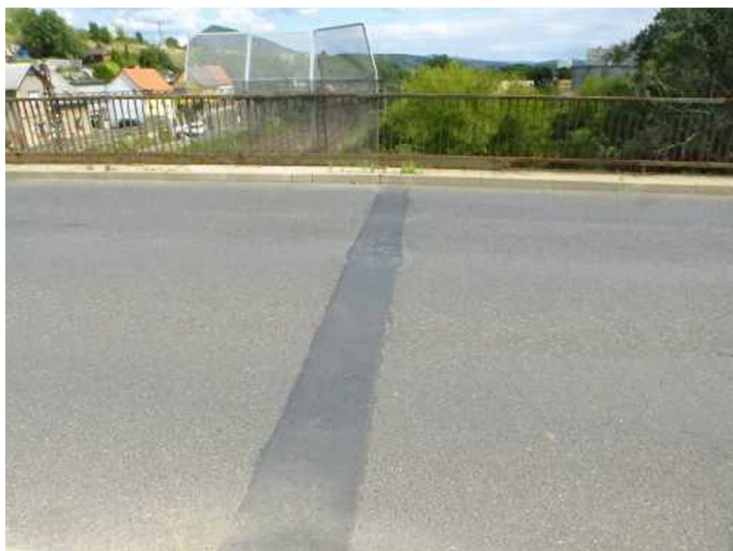
Deformace štítu protidotykové zábrany.
