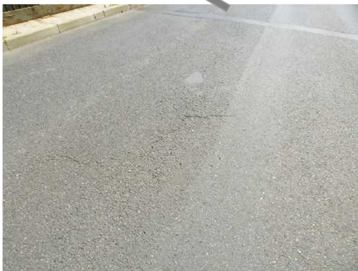
Nepravidelná trhlina v krytu vozovky.
