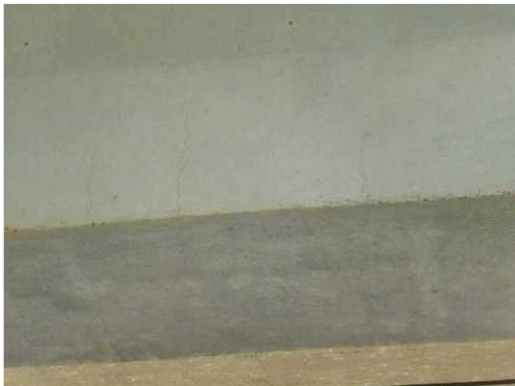
Trhliny na spodním líci stativa pilíře.
