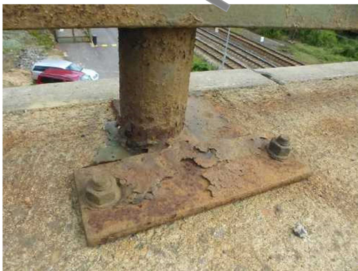
DTTO v místě kotvení do římsy.
