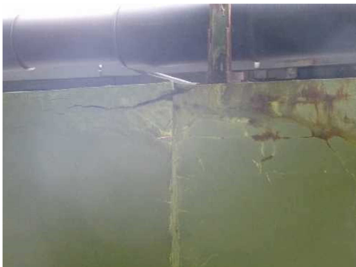
Výrazně odražená krycí vrstva nad korodující výztuží u dilatační spáry.
