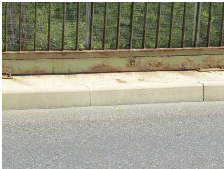
Koroze okopového plechu protidotykové zábrany.
