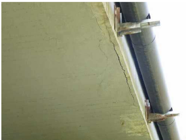
Odražená krycí vrstva nad korodující výztuží v hraně desky.
