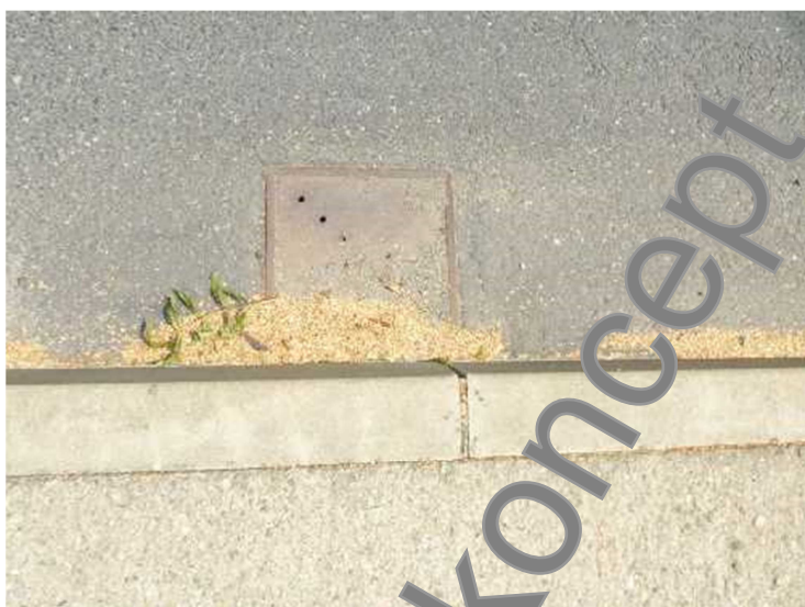
Odvodňovač je zakrytý děrovaným plechem.
