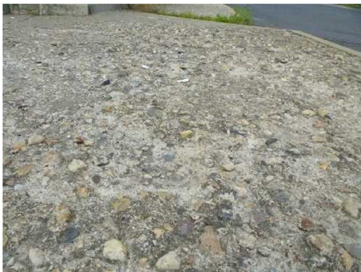
Degradace povrchu betonu chodníku.
