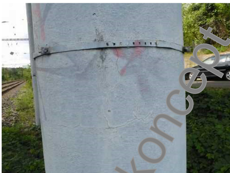
Trhliny na líci stojky pilíře.
