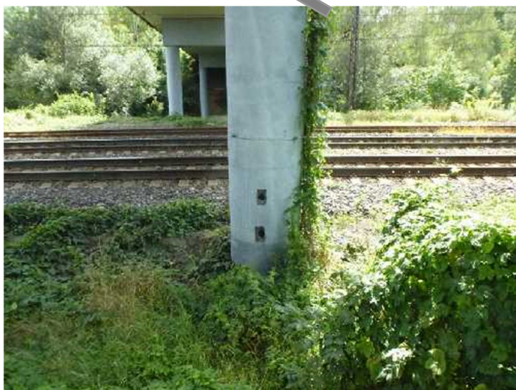
Otevřené schránky SZ ve stojkách pilíře.
