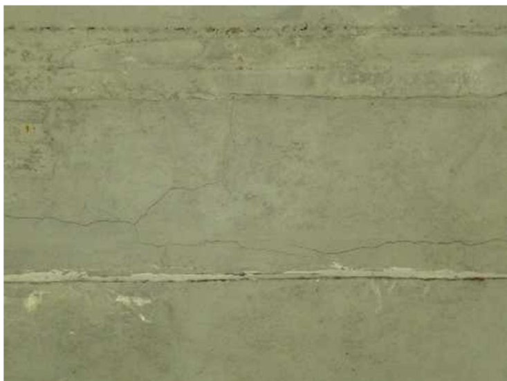
DTTO - trhliny v okolí dilatační spáry.
