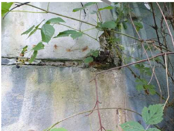
Odražená krycí vrstva na boku desky v místě uložení na opěru.
