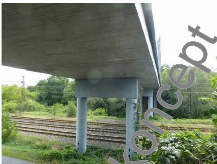
Podhled NK od O5.
