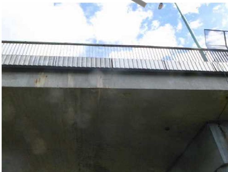
Typické poruchy v oblasti dilatační spáry.
