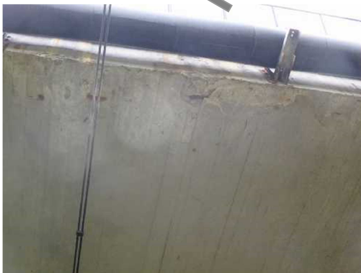
Typická degradace betonu a koroze obnažené výztuže v místě zatékání na spodní líc desky. Koroze konzol trubního vedení.
