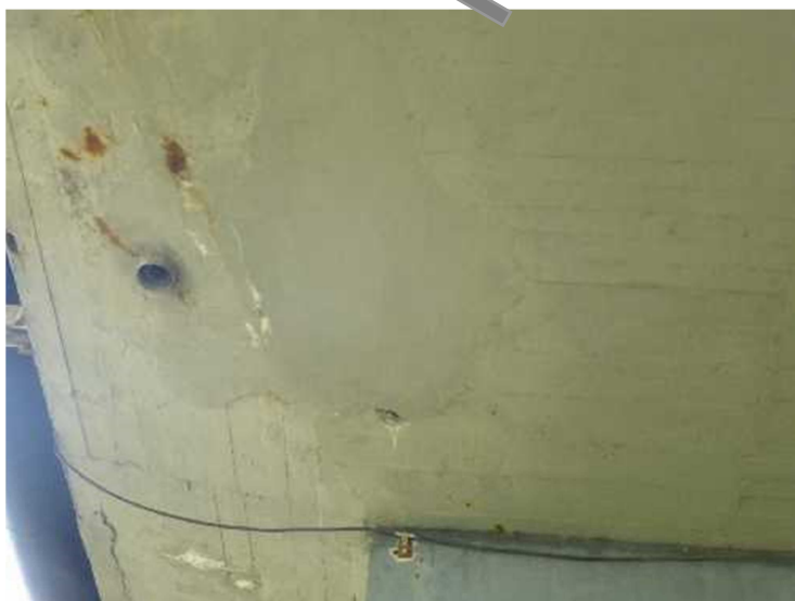
Průsaky v okolí svodů odvodnění.
