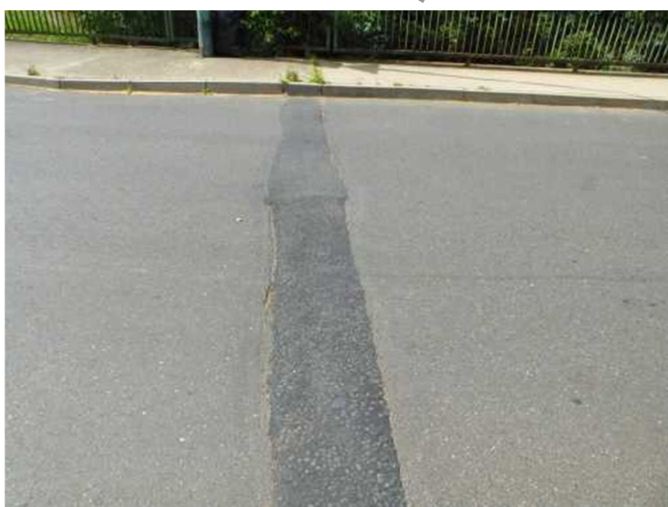
Poruchy mostního závěru.
